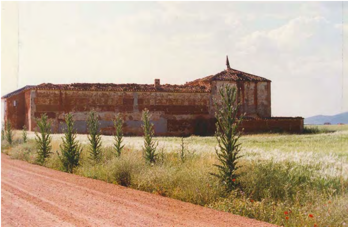
Vista de la Casa del Capitán sobre el Camino Real de la Plata, con la sierra de Alambra y Puerto de Vallehermoso al fondo.
