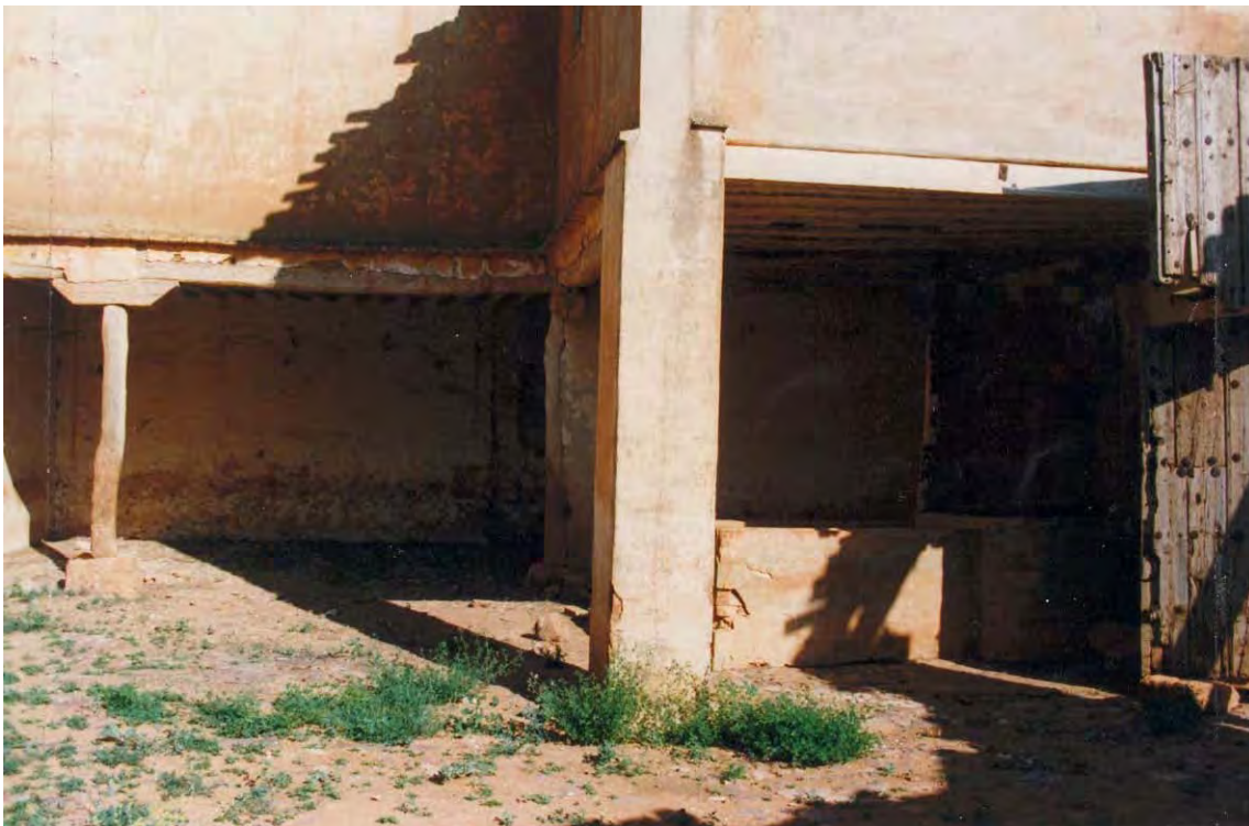
Vista del interior del patio con soportales y pila abrevadero al entrar.
