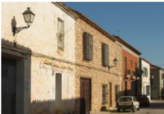
10. Situación actual de la fachada principal
